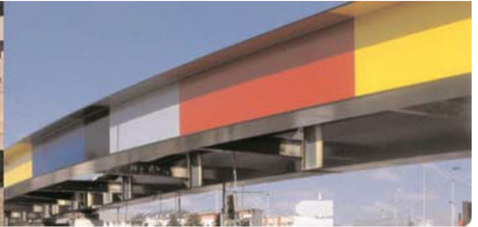
Pont du Tramway à Créteil-France
