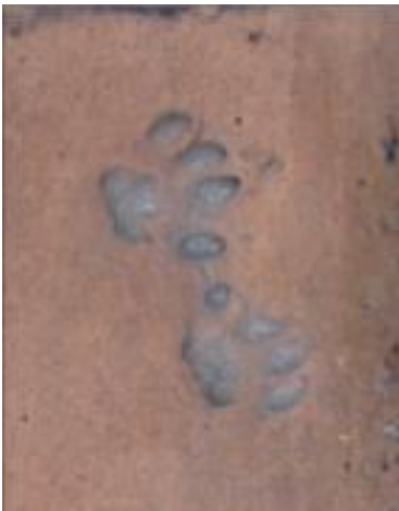
Tegola con impronta zampe di gatto recuperata sulle coperture della Ca' Granda, Milano
